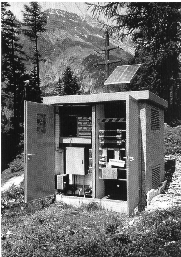
Bild 2. Transformatorenstation Bergün-Toua. Da diese Station nur im Winter zur Beleuchtung der Schlittelbahn in Betrieb ist, musste zur Sicherstellung der Stromversorgung der Starkbebenstation während des Sommerhalbjahres eine Solaranlage installiert werden.
