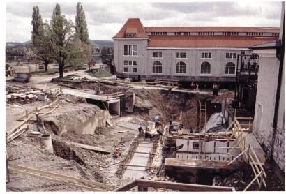
Bild 23. Anbindung des Energieableitungskanals ans Umspannwerk.
