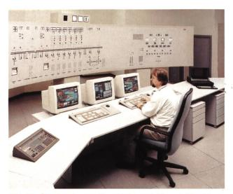
Bild 27. Schaltwarte mit Mosaiktafel und Mensch-Maschinen-Kommunikations- (MMK-)Stationen.
