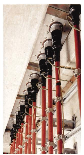
Bild 25. Einführung der Generatorableitungen über Steckverbindungssysteme in die 6,8-kV-Schaltanlage.
