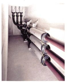
Bild 24. Hochstrom-Schienensystem mit Erdung.
