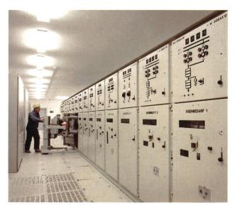
Bild 26. 6,8-kV-Schaltanlage, Hauptfeldseite.
