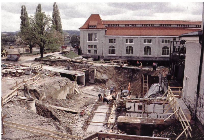
Bild 23. Anbindung des Energieableitungskanals ans Umspannwerk.
