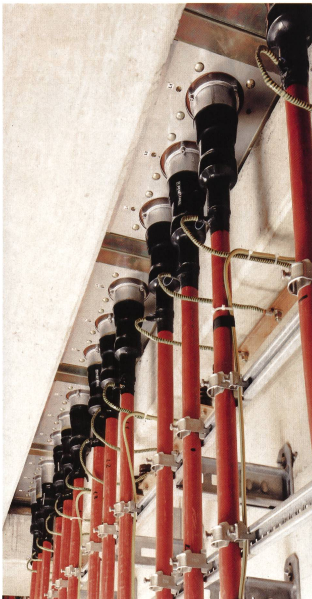
Bild 25. Einführung der Generatorableitungen über Steckverbindungssysteme in die 6,8-kV-Schaltanlage.
