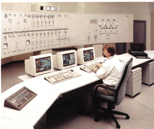
Bild 27. Schaltwarte mit Mosaiktafel und Mensch-Maschinen-Kommunikations- (MMK-)Stationen.
