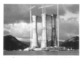
Bild 1. Ölplattform Gullfaks C. Betonieren der vier Schäfte mit Gleitschalung im Fjord bei Vats.
