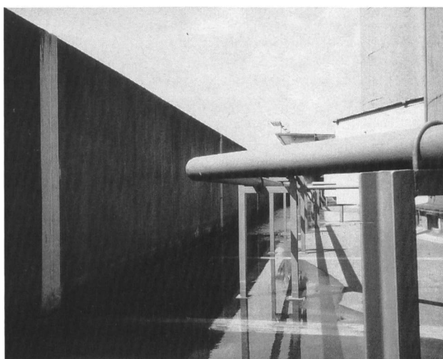
Bild 5. Abdichten von Elementfugen in einem beschichteten Auffangkanal mit dem Sikadur-Combiflex-System.
