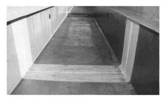
Bild 4. Mit dem Sikadur-Combiflex-System abgedichtete Wandund Bodenfugen einer Auffangwanne.
