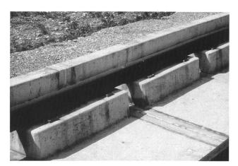
Bild 6. Das Sikadur-Combiflex-System zur Abdichtung von Bodenfugen in einem Umschlagplatz (Bahn).
