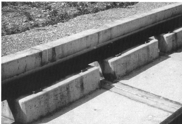
Bild 6. Das Sikadur-Combiflex-System zur Abdichtung von Bodenflächen in einem Umschlagplatz (Bahn).
