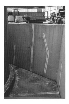
Bild 5. Abdichten von Elementfugen in einem beschichteten Auffangkanal mit dem Sikadur-Combiflex-System.
