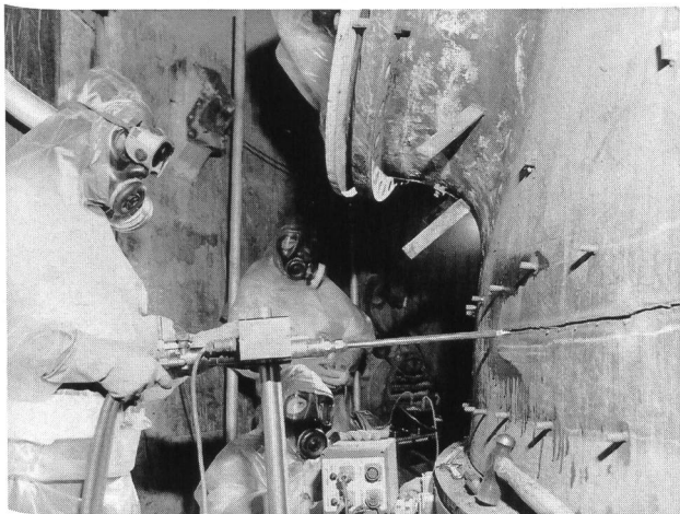
Figure 1. Matériel de découpage à l'oxypropane pour découper un métal épais.
