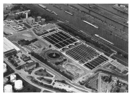
Die *chemische Stufe* entfernt den Phosphor, der zusammen mit dem Nährstoff Stickstoff bei einem Überangebot zu einem unerwünscht hohen Algenwachstum in den nachfolgenden Gewässern führen kann.
