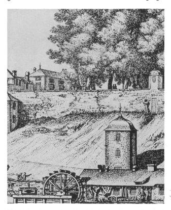
Bild 1. Das Pumpwerk an der Schipfe. Das Pumpwerk, erbaut 1661- 1667 und abgebrochen 1869, versorgte den Brunnen auf dem Lindenhof. Das mit Wasserkraft betriebene Werk pumpte Wasser in das heute noch erhaltene Türmchen auf der Lindenhof-
