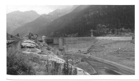
Bild 1. Betonstaumauer mit Dichtungsgewölben aus Granitmauerwerk auf der Wasserseite nach dem Entleeren des Stausees
