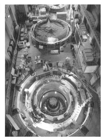
Zwei vertikale Francisturbinen während der Montage in der Zentrale des Kraftwerks Atatürk. (Bild Sulzer-Escher Wyss)
