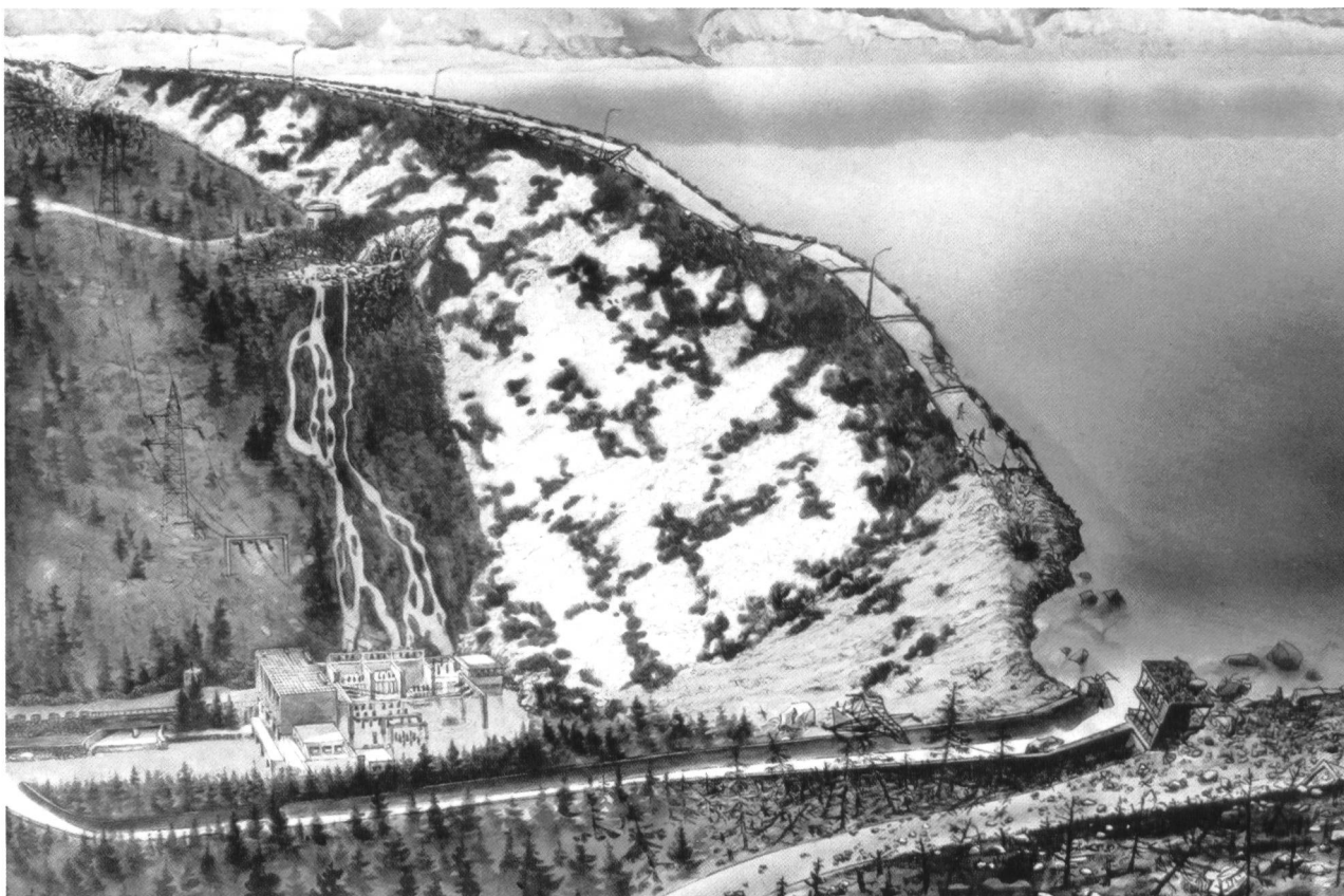
Bild 3. Gemälde der Luftseite mit den Schadstellen: rechts Krater der Sprengladungen 1 bis 3; in Kronenmitte Setzung infolge Sprengung 4; links oben Krater der Sprengladung 5; darunter schlammhaltige Wasserausstritte aus einem der Zugänge zum Sohlgang (aus: Int. Workshop on Dam Safety Evaluation, suppl. vol.).
