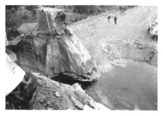
Bild 2. Die von den Sprengladungen 1 bis 3 verursachten Schäden beim linksufrigen Hochwasserüberfall (aus: Int. Workshop on Dam Safety Evaluation, suppl. vol.).
