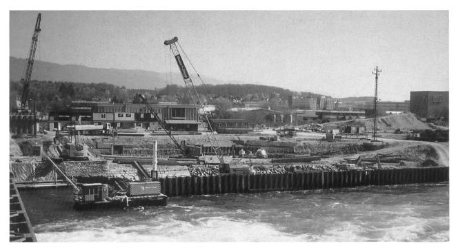
Bild 3. Am linken Ufer des Nidau-Büren-Kanals wird die Baugrube für den Bau des Wasserkraftwerkes Brügg erstellt. Im Hintergrund die Industriezone Brüggmoos und der Jura.
