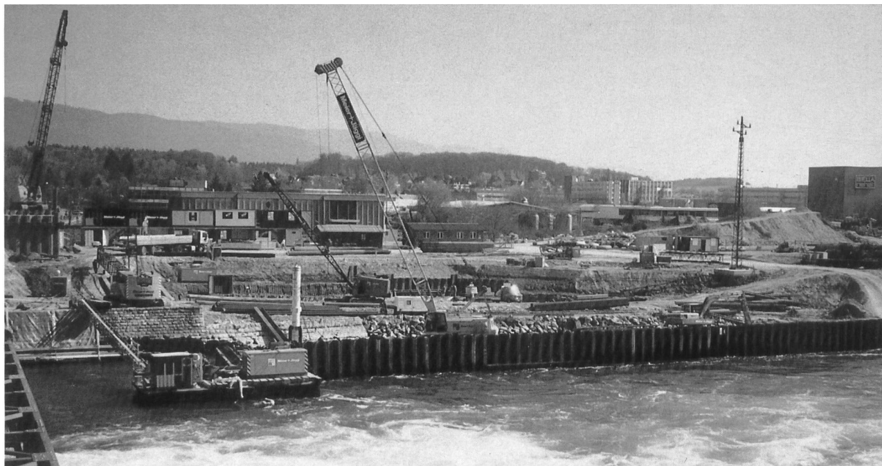
Bild 3. Am linken Ufer des Nidau–Büren-Kanals wird die Baugrube für den Bau des Wasserkraftwerkes Brugg erstellt. Im Hintergrund die Industriezone Bruggmoos und der Jura.
