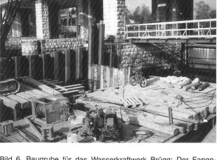
Bild 6. Baugrube für das Wasserkraftwerk Brügg: Der Fangedamm wird an den ersten Wehrpfeiler angeschlossen. Rechts, unter dem Hilfssteg: Wehrdammbalken, eingesetzt als Teil der Baugrubenumschliessung.
