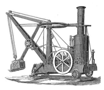
Löffelbagger aus Franz Luckenbacher: Die Schule der Mechanik und Maschinenkunde. Spamer: Leipzig 1857. «Die Ausgrabemaschine... (kann) in 12 Stunden 1500 Cubikklafter (10 000 m³) Erde bewegen, wobei sie für vier Thaler Kohlen verbraucht. Die Maschine selbst kostet etwa 10 000 Thaler.»
