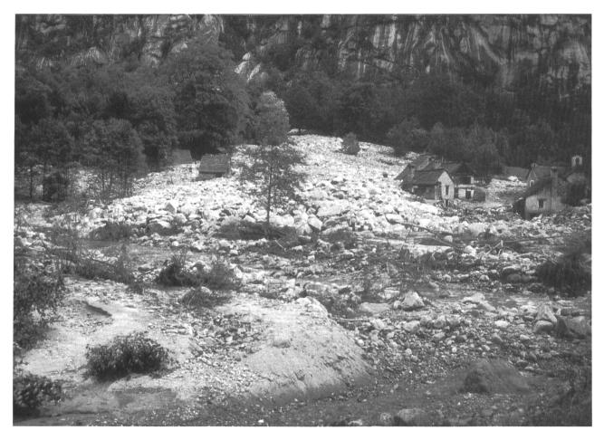
Bild 6. Faèd in Bavonatal/TI nach dem Murgang vom 31. August 1992. Rund 140 000 m<sup>3</sup> Schlamm- und Geschiebemassen ergossen sich über den Weiler. Zwei Personen fanden dabei den Tod. Foto: *D. Rickenmann*, WSL.
