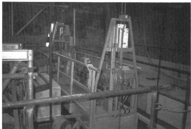
Bild 6. Motor-Hängegerüst für Personentransporte im Schacht.
