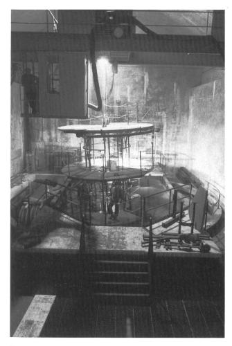
Bild 5. Dreistöckige Arbeitsbühne, bereit zum Absenken in den 130 m tiefen Schacht Peccia.
