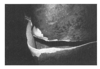
Bild 4. Schaden an der Schachtpanzerung Peccia vom April 1990. Stahlstärke 8 bis 12 mm.
