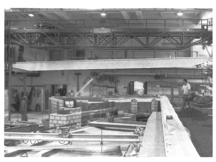
Bild 1, links. Mit einem Pneukran wird ein Träger des neuen Kranes auf die Dachterrasse des VAW-Gebäudes gebracht. Anschliessend wird er durch eine Fensterlücke in die Versuchshalle geschoben.
