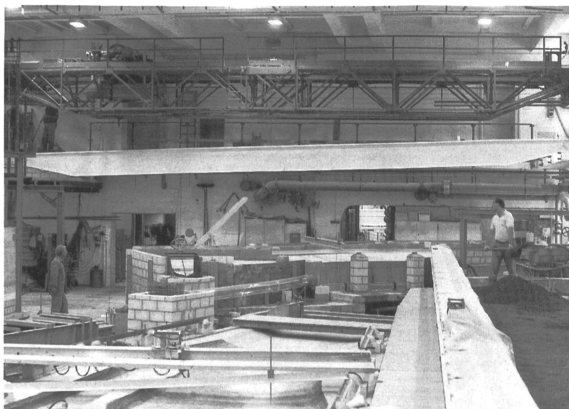
Bild 1, links. Mit einem Pneukran wird ein Träger des neuen Kranes auf die Dachterrasse des VAW-Gebäudes gebracht. Anschliessend wird er durch eine Fensterlücke in die Versuchshalle geschoben.
