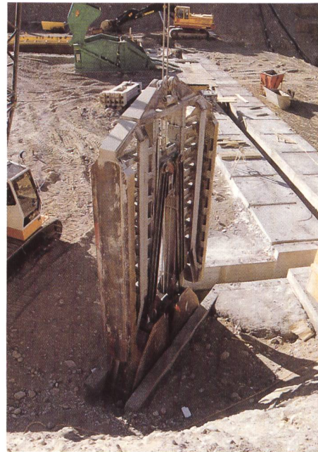
Einphasendichtungswand in Ausführung.
