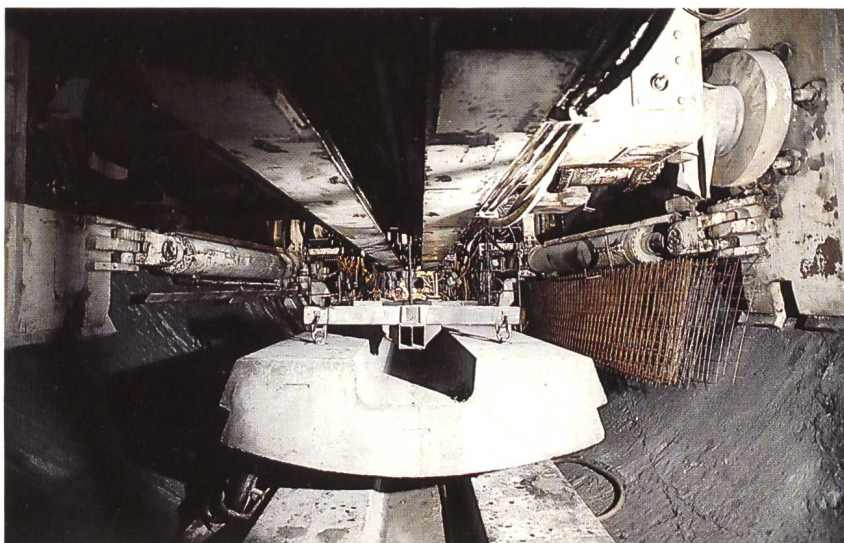
Bild 4.3. Sohlübbinge als temporäre Schienenschwellen werden im Baulos 3 in die Stollenverkleidung integriert.
