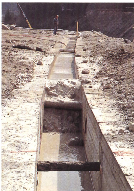
Einphasendichtungswand in Ausführung.
