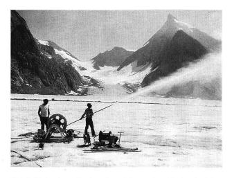
Bild 2. Testlauf vor Beginn einer Bohrung im «Konkordiaplatz» (Grosser Aletschgletscher): Überprüfung der Düse an der Bohrstange. Links im Bild die Schlauchwinde.
