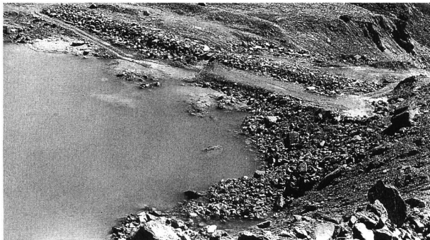
Bild 4: Blockwurfdamm am See 1 des Grubengletschers. Die spektakuläre Erosion auf der Luftseite des Dammes entstand bei den Ausbrüchen von See 3 in den Jahren 1968 und 1970.
