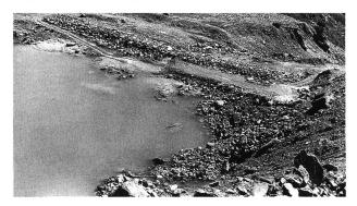
Bild 4: Blockwurfdamm am See 1 des Grubengletschers. Die spektakuläre Erosion auf der Luftseite des Dammes entstand bei den Ausbrüchen von See 3 in den Jahren 1968 und 1970.
