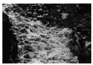
Bild 4. Kleineres Monsunhochwasser mit einem Abfluss von 40 bis 50 m³/s. Das Bild zeigt die Rampe aus Bild 2, diesmal vom rechten Ufer aus gesehen. Erkennbar sind von links oben nach rechts unten eine «Buhne», ein CAB-Depot sowie ein «Blockwurf» (Foto: ITECO).
