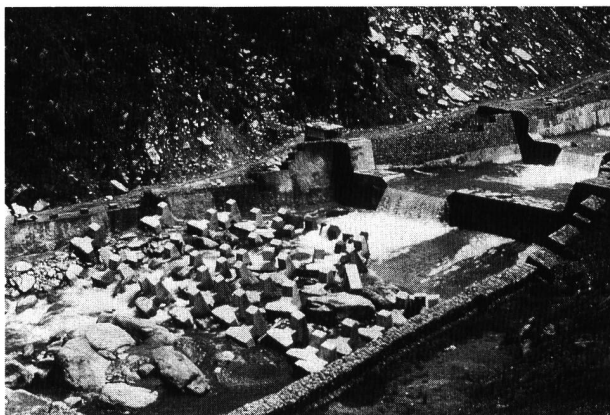
Bild 3. Blockrampe aus künstlichen Betonelementen als Kolk-schutz im Anschluss an den Fallboden der untersten Sperre.
