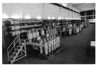
In Singapur wurde das Unterwerk Senoko der Public Utilities Board Singapore um weitere elf Felder auf insgesamt 30 erweitert. Die für 66 kV Nennspannung bestimmte Anlage sichert die Stromverteilung im Zentrum der Stadt. (Foto: Sprecher Energie)
