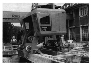
Die vollautomatische Rechenreinigungsmaschine in Augst, dahinter der Portalkran 85/20 t.
