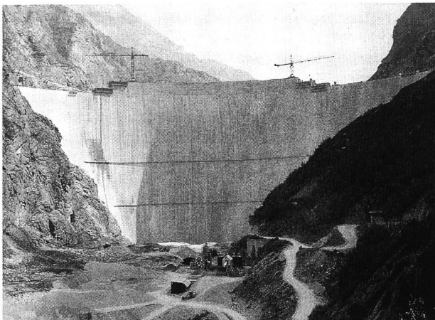
Bild 4. Sommer 1990, Ansicht von der Luftseite mit Betonzentrale am Mauerfuss.
