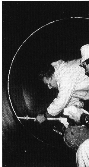
Bild 9, links. Sanierungsbedürftiger Dichtstoff in einer Bewegungsfuge des Klärbeckens wurde mit der Membranabdichtung Sikadur-Combiflex überklebt.
