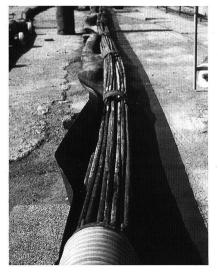
Figure 8. Détail d'un tirant. Au premier plan le début de la zone d'ancrage avec sa gaine métallique. Au second plan, mise en place et collage de la gaine PVC sur la longueur libre.
