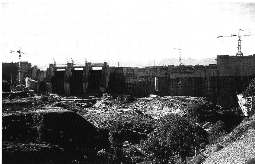
Figure 1. Vue aval en cours de surélévation.
