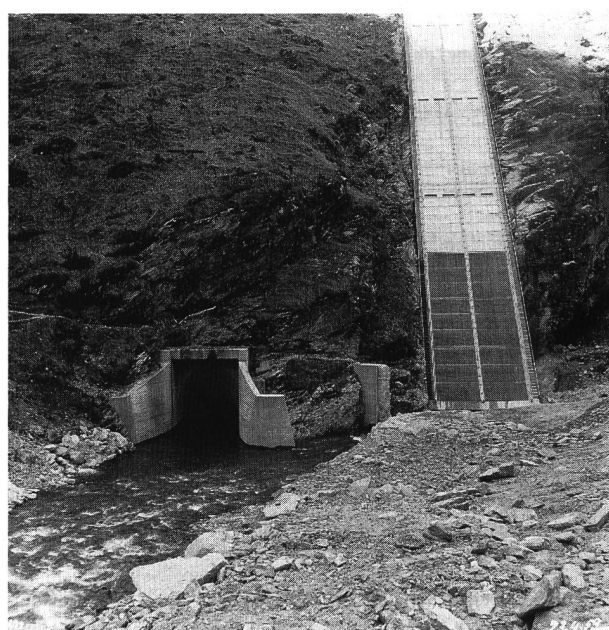
Figure 2. La retenue de Malvaglia à sec lors de la construction. De gauche à droite: la vidange de fond, la prise d'eau, le barrage-vôte.
