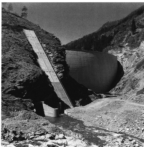
Figure 2. La retenue de Malvaglia à sec lors de la construction. De gauche à droite: la vidange de fond, la prise d'eau, le barrage-vôte.
