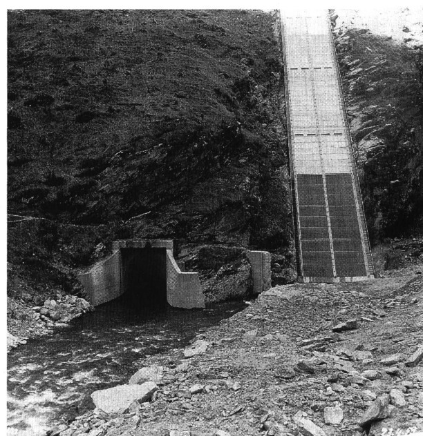
Figure 2. La retenue de Malvaglia à sec lors de la construction. De gauche à droite: la vidange de fond, la prise d'eau, le barrage-voûte.
