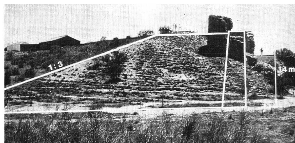
Bild 6. Überreste der gebrochenen Sperre Alcantarilla, 20 km südlich von Toledo, mit Eintragung des ehemaligen Dammquerschnittes (Foto des Autors).
