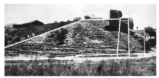
Bild 6. Überreste der gebrochenen Sperre Alcantarilla, 20 km südlich von Toledo, mit Eintragung des ehemaligen Dammquerschnittes (Foto des Autors).
