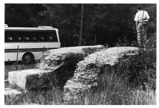
Bild 1. Wahrscheinliche Überreste der rechtsufrigen Hochwasserentlastung an der römischen Aniene-Sperre bei Subiaco, 50 km östlich von Rom (Foto des Autors).
