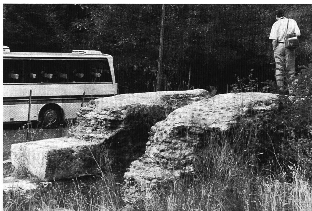
Bild 1. Wahrscheinliche Überreste der rechtsufrigen Hochwasserentlastung an der römischen Aniense-Sperre bei Subiaco, 50 km östlich von Rom (Foto des Autors).
