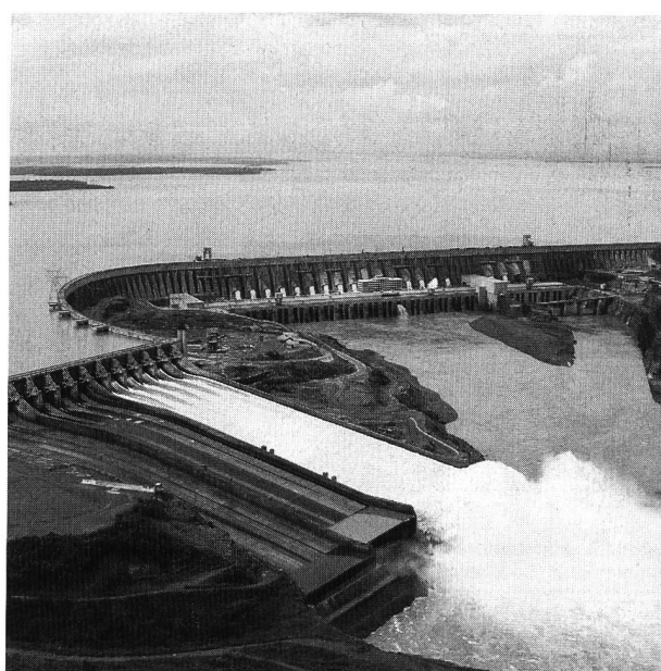
Bild 2. Das Wasserkraftwerk Itaipú (Unterwasserseite) – Kraftwerk und Hochwasserüberfall (links).
