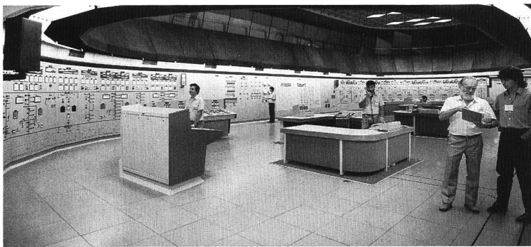
Bild 3. Zentrale Bedienungsstelle für alle Einheiten des Wasserkraftwerks Itaipú.
