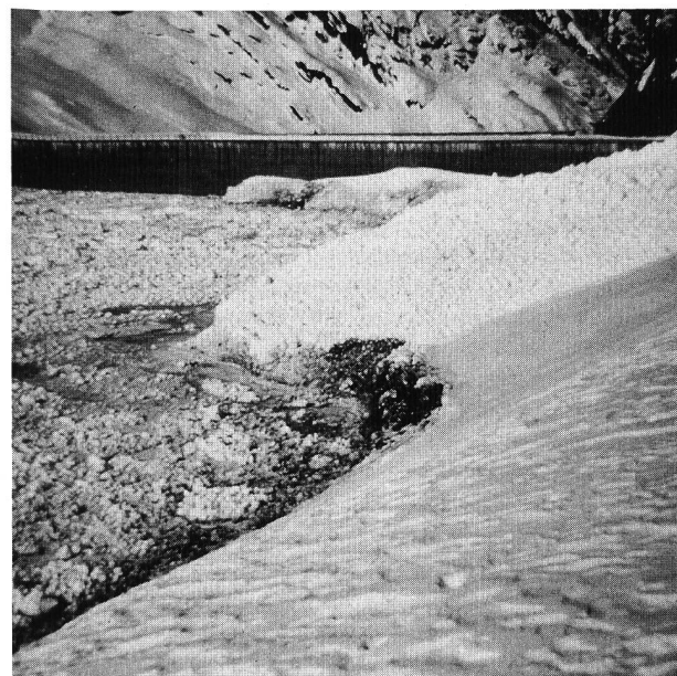
Bild 7. Blick auf das rechte Widerlager der Räterichsbodenmauer und den Kegel der einmündenden Gärstenbachlawine. Die Lawine durchbrach die Eisdecke und führte zur Wellenbildung, was an der Auflaufhöhe an den Ufern sichtbar wurde.
