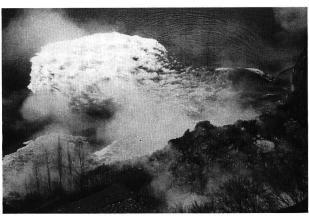
Bild 2. Schwallwelle infolge eines Felssturzes: Die bei einer Sprengung im Steinbruch Kehrsiten (10.3.1982) in den See stürzenden Felsmassen verursachten eine Grundwelle (Foto Hügli Sprengtechnik AG, Bern).
