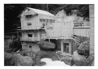
Bild 4. Zentrale, Zulaufkanal und Kiesspülschütze kurz vor Rohbauvollendung.
