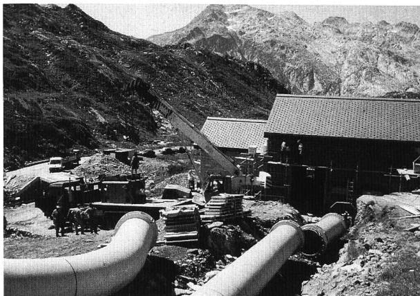
Bild 4. Abladen des Generators vor der neuen Kraftwerkzentrale Sella.
