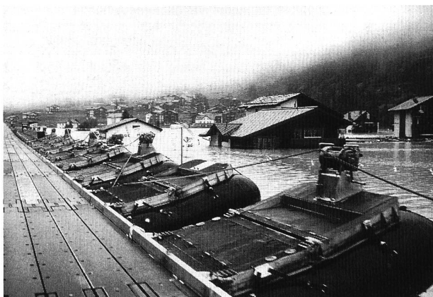
Bild 4. Bei Unwettern am 16. Juni 1991 und am 8. August 1991 wurden durch den Rückstau der Vispa Teile des Dorfes Randa überflutet. Die schwimmende Schlauchbootbrücke sicherte die Verbindung ins obere Mattertal.
