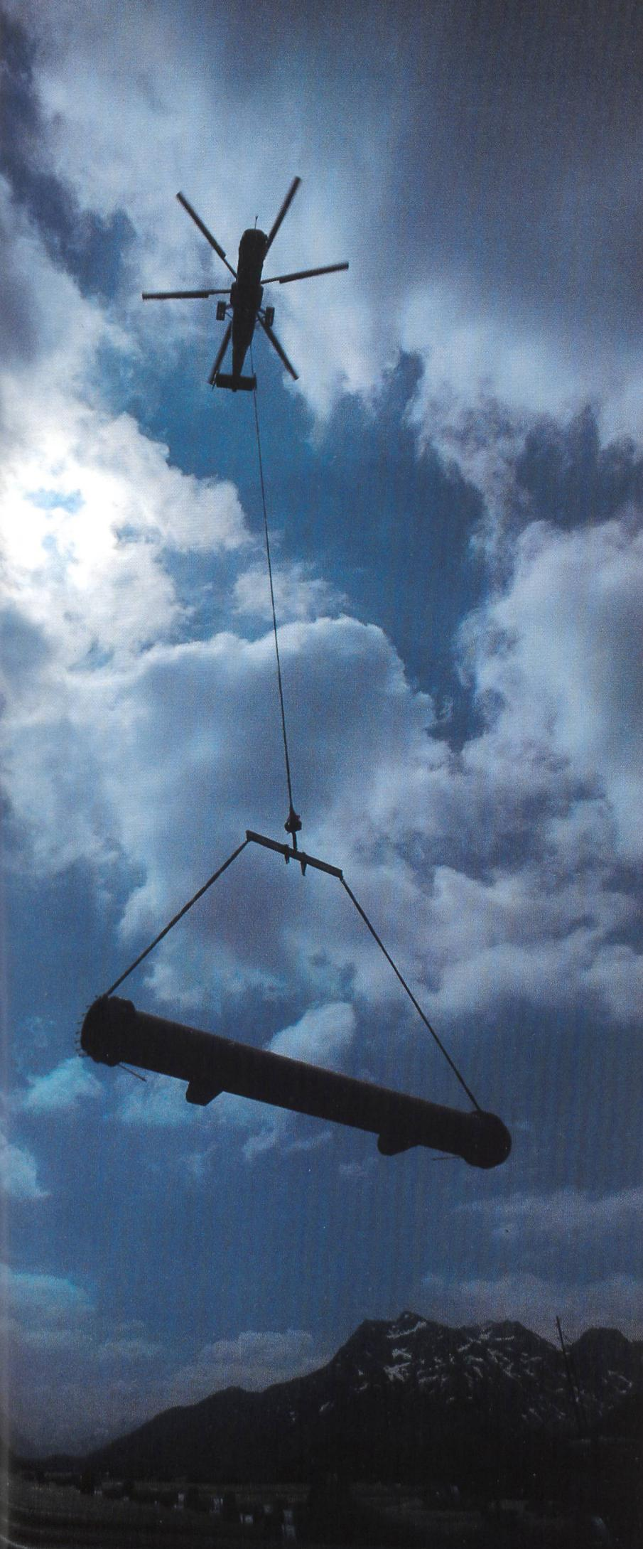
Einfliegen von Druckrohrschnüren mit dem Helikopter. Siehe auch «Sella – ein Kleinkraftwerk am Gotthard», Seite 82.
