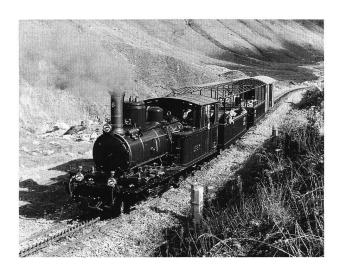
Bild 2. Nahezu rauchlos arbeitet sich die *Weisshorn* die Zahnstange hinauf. Bei guter Kohle und geübtem Heizer sind die gut revidierten Dampfloks auch bei voller Maschinenleistung fast rauchfrei.
