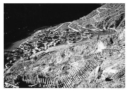
Bild 3. Die durch die katastrophalen Stürme vom Februar 1990 sowie frühere Lawinenniedergänge zerstörten Schutzwälder bieten in den Alpenregionen keinen ausreichenden Schutz mehr vor Murgängen und Rüfen. Das Bild zeigt den entblössten Hang oberhalb Curaglia (GR) mit neu erstellten Lawinenverbauungen, die teilweise durch die Rüfen vom September 1991 wieder zerstört wurden.
