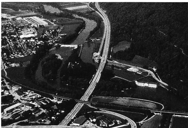
Bild 1. Das Kraftwerk Ruppoldingen, eines der ersten grösseren Kraftwerke der Schweiz. Links oben das Stauwehr, anschliessend rechts der Kanal, wie er damals bei Kraftwerken üblich war. Im alten Aarelauf unterhalb des Stauwehrs liegen die Ruppoldingen Inseln.
