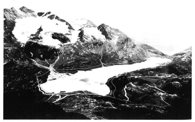
Bild 1. Der Lago Bianco von Süden gesehen. Rechts das Gambrena-Delta, das überstaut wird. Eingezeichnet sind die geplanten Staumauern und die Uferlinie des um 25 m höher zu stauenden Sees. Im Vordergrund ist die Bernina-Pass-Strasse zu erkennen.
