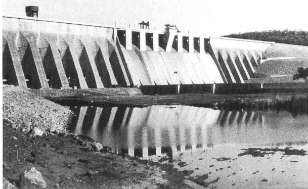
Bild 1. Gewichtsmauer mit Pfeilerköpfen als Hauptteil der 1,6 km langen Talsperre Manantali in Mali.
