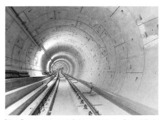
Bild 1. Tunnelauskleidung mit Stahlbetontübbingen – Baulos Wöhrder Wiese, U-Bahn Nürnberg.
