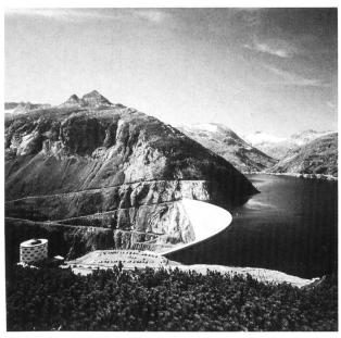
Bild 2. Vollstau der Kölnbreinsperre nach der Sanierung
