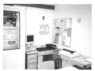
Bild 5. Der Fernmessanlageteil im Betriebsgebäude Solis. Links im Schaltschrank der Messcomputer der Firma Huggenberger AG und darüber das PTT-Modem für die Verbindung nach Zürich. Auf dem Schreibtisch der XT-kompatible PC mit Bildschirm, Tastatur und daneben der Matrix-Drucker.
