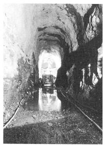
Bild 5. Kavernenzentrale Unteraa. Schalwagen für die Betonverkleidung der Kalotte.
