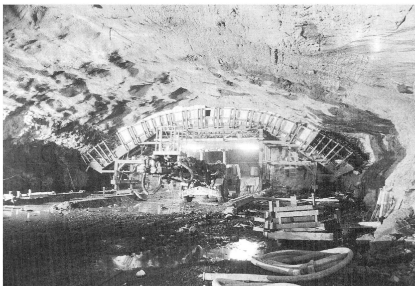
Bild 5. Kavernenzentrale Unteraa. Schalwagen für die Betonverkleidung der Kalotte.
