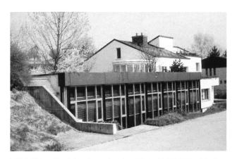
Bild 1. Dieser längliche eingeschossige Bürotrakt ( $10 \times 20$  m) in Jona (SG) ist an ein bestehendes Wohnhaus angebaut worden. Das ganze Gebäude ist erdberührt und erdbedeckt, so dass das Gelände über dem Bürotrakt wieder als Grünfläche dient. Foto: Werner Peyer
