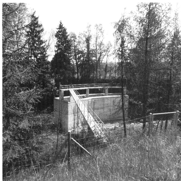
Bild 9. Hochwasserentlastungsbauwerk mit Zugangssteg (Blick vom Stassendamm).
