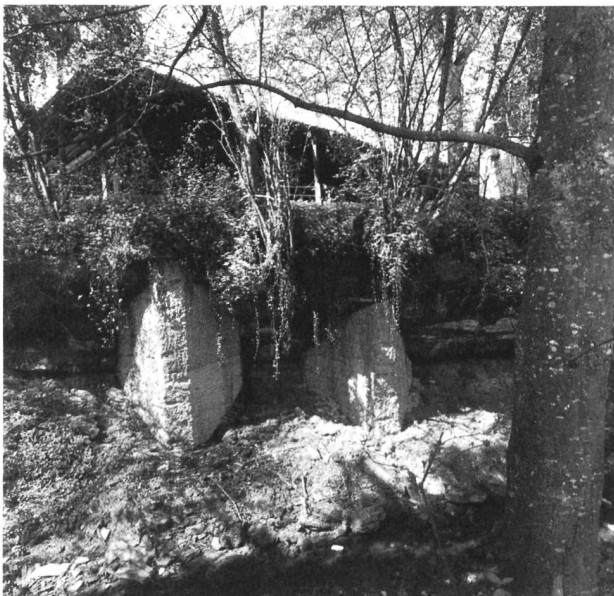
Bild 4. Überhängende Felspartien, mit Betonrippen unterfangen.
