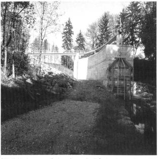
Bild 10. Hochwasserentlastungsbauwerk mit Grobrechen vor Drosselöffnung.
