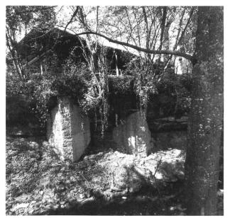
Bild 4. Überhängende Felspartien, mit Betonrippen unterfangen.
