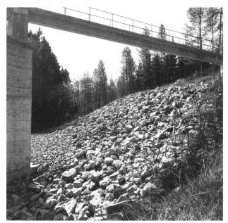
Bild 3. Blockschüttung zur Sicherung der Dammböschung.
