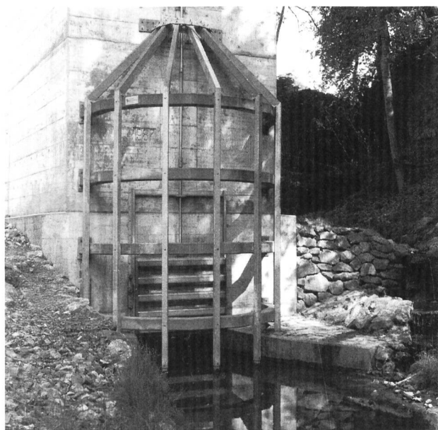
Bild 7. Grobrechen vor Einlauf Drosselöffnung.
