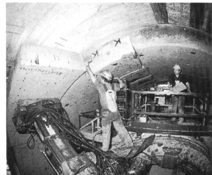
Bild 2, rechts. Einbau und Festlegen der Stahlbetontübbinge für die Auskleidung des Eurotunnels mit Robotern.
