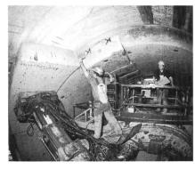
Bild 2, rechts. Einbau und Festlegen der Stahlbetontübbinge für die Auskleidung des Eurotunnels mit Robotern.
