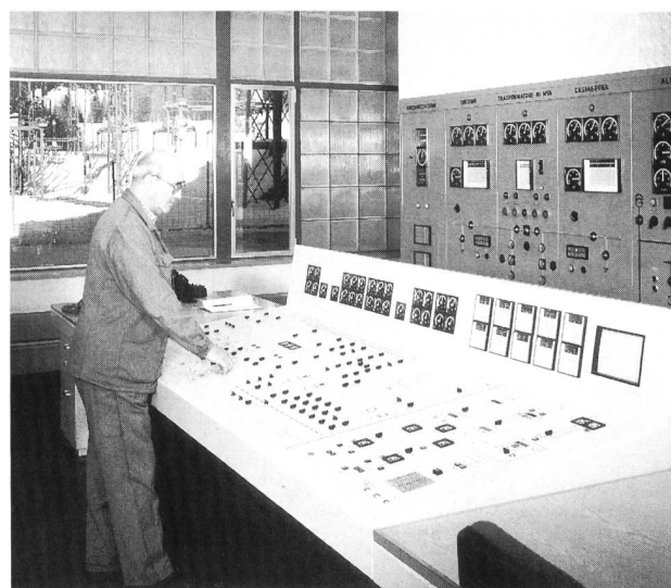
Bild 6. Am Bedienungspult in Löbbia werden neben der gewählten Betriebsart die Niveaumesswerte, die disponiblen Regelleistungen, die Kennlinienparameter sowie die Stellgrössen in [%] und [MW] angezeigt. Ferner werden der Zufluss, die turbinierten Wassermengen in den Kraftwerken sowie das Stau-, Pump- und Turbinenvolumen angezeigt.
