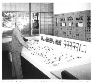
Bild 6. Am Bedienungspult in Löbbia werden neben der gewählten Betriebsart die Niveaumesswerte, die disponibeln Regelleistungen, die Kennlinienparameter sowie die Stellgrössen in [%] und [MW] angezeigt. Ferner werden der Zufluss, die turbinierten Wassermengen in den Kraftwerken sowie das Stau-, Pump- und Turbinenvolumen angezeigt.
