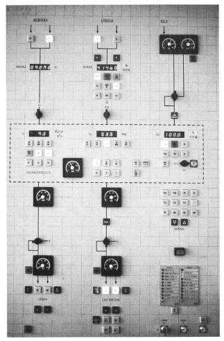
Bild 5. Anzeigetafel für den Kaskadenregler in Löbbia.
