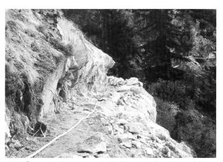
Bild 7. Über weite Strecken musste das Trasse der Hangleitung Schiessbach-Rigi ausgesprengt werden.
