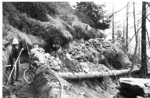
Bild 8. Das Trasse für die Hangleitung wird vorbereitet. Zweimal mussten rund 1300 m teils in felsigem und exponiertem Gelände überwunden werden.
