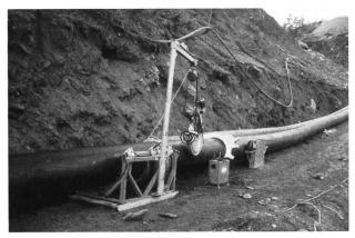
Bild 9. Die dickwandigen Kunststoffrohre der Hangleitungen wurden in einem thermischen Schweissverfahren miteinander verbunden.
