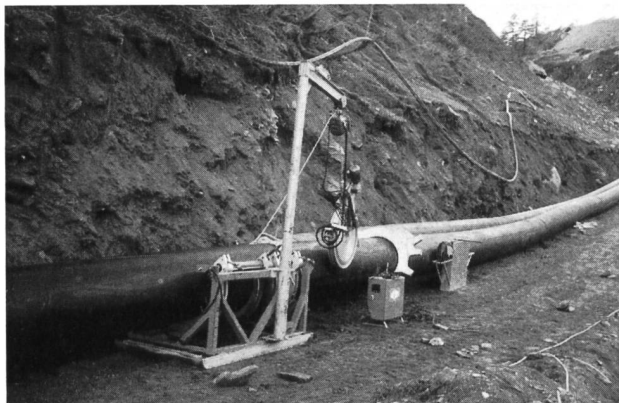
Bild 9. Die dickwandigen Kunststoffrohre der Hangleitungen wurden in einem thermischen Schweissverfahren miteinander verbunden.
