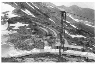
Bild 6. Bereits nimmt der Damm Konturen an. Erkennbar sind die Stützkörperschichten mit dem Böschungsschutz beidseitig des Kerns. Im Vordergrund des Barackendorf und die Reparaturwerkstätte.
