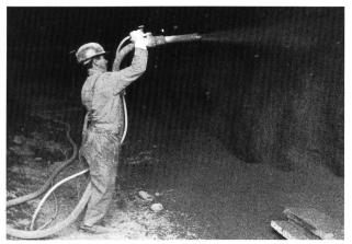
Düsenführer beim Spritzen in einem Freispiegelstollen aus dem besprochenen Buch «Spritzbeton» von *P. Teichert*, S. 10.
