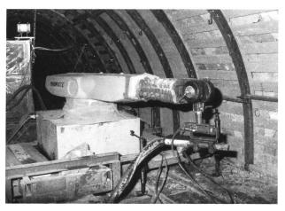
Bild 3. Als Spritzbetonroboter umgerüsteter Industrieroboter beim Einsatz unter Tage.
