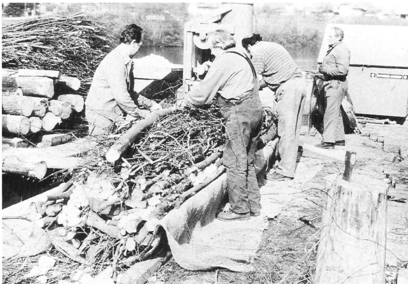
Bild 1, links. Für die Revitalisierung des Aareufers im Stau des Kraftwerks Wynau werden Senkfaschinen in Handarbeit hergestellt. Äste werden mit Steinen beschwert, und dann wird das Ganze in ein verrottbares Jutegewebe eingepackt. Vom Ponton aus kann dann die Faschine am Ufer versenkt werden.
